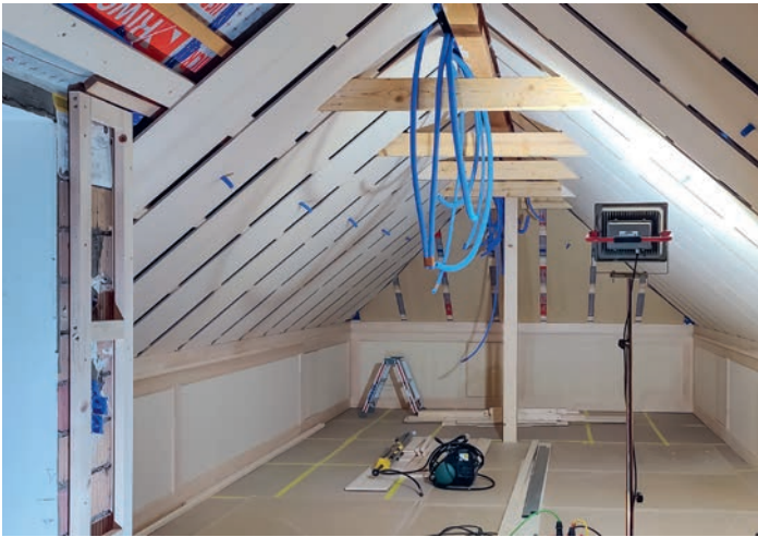
Täuschend echt: Montage der Füllungsfelder, deren Stösse mit profilierten Massivholzfriesen abgedeckt wurden.
