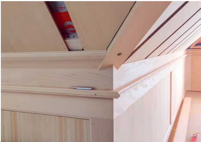
Recht knifflig: Bis solche Anschlüsse perfekt passen, muss man meist nochmals nachscheiden.
